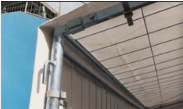
5. Dachplane und Giebelplane mit Schnallriemen befestigen
