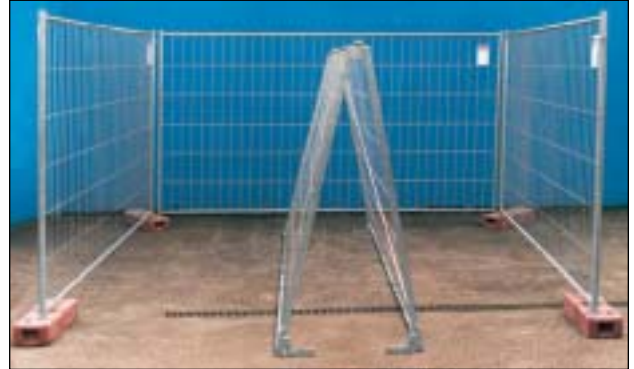
2. Dachgitter mittig zwischen die Bauzäune stellen
