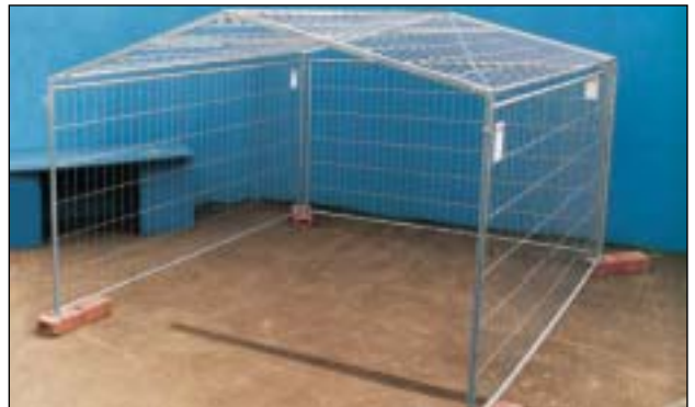
4. Dachgitter in die zweite Seite der Bauzäune stecken
