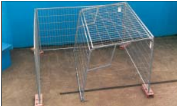
3. Dachgitter auf einer Seite in die Bauzäune stecken
